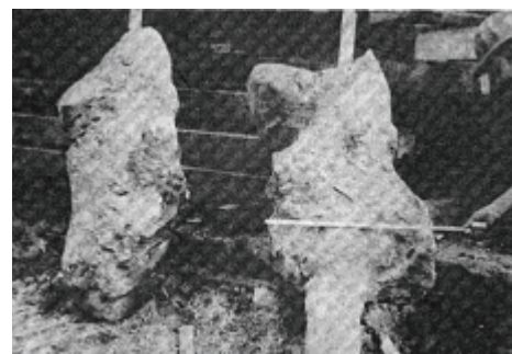
Fig. 95 (d) Compaction Bulb
